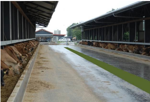
Her kunne, som på visualiseringen, anlægges en afledningsgrøft på området mellem bygningerne. Foto: Videncentret for Landbrug.
