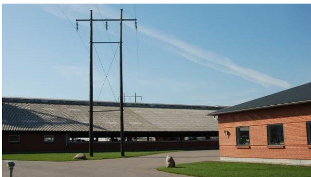
Ved store landbrugsbygninger og anlæg er der tale om betydelige tagflader, hvor regnvand skal afledes. Foto: Videncentret for Landbrug.
