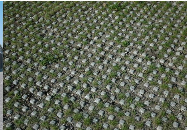
Græsarmering kan være med til at gøre arealet mere naturligt. Man skal dog være opmærksom på slitage ved tung trafik. Foto: Videncentret for Landbrug.
