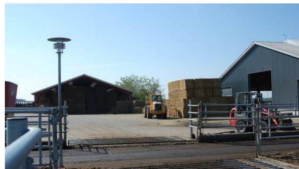
Der findes desuden store befæstede arealer mellem de forskellige produktionsbygninger. Foto: Videncentret for Landbrug.
